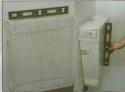
Zavesiť radiátor na konzoly a skontrolovať vodorovnú a zvislú polohu
