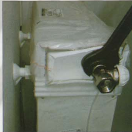
Namontovať odvzdušňovacie ventily
