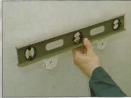
Skontrolovať výškovú nŕvelizáciu nastavenia konzol
