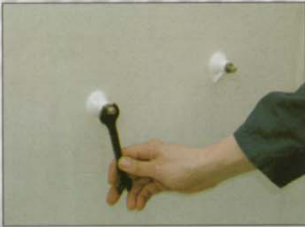
Navŕtať otvory do steny, namontovať a opatrne zafixovať konzoly
